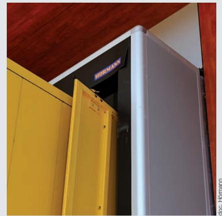
Gros plan sur l'habillage périphérique réalisé en panneaux d'acier de 20 mm d'épaisseur à isolation thermique.
